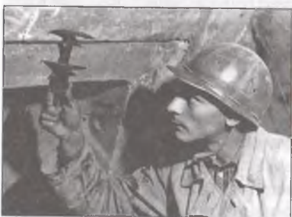
Рис. 7.2. Измерение величины раскрытия стыков сборной железобетонной отделки
