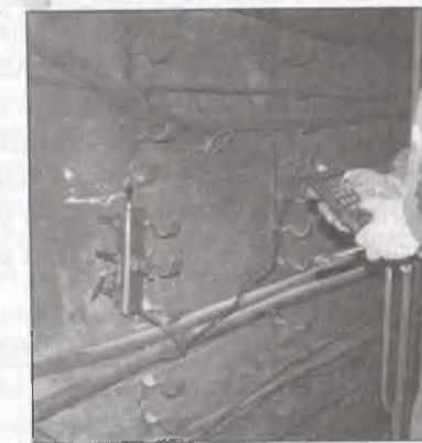
Рис. 7.4. Определение прочности бетона методом отрыва со скалыванием
