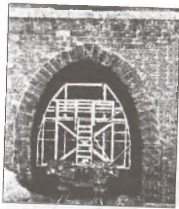
Рис. 4.4. Платформа с рамой негабаритности 4-й степени в тоннеле старой постройки
