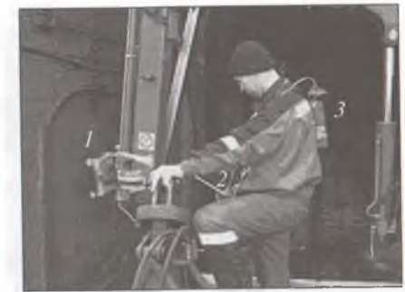
Рис. 7.6. Зондирование обделки тоннеля и грунтового массива на глубину 5 м с использованием георадара «Око-2»: 1 — антенный блок АБ-400; 2 — ноутбук; 3 — блок питания
